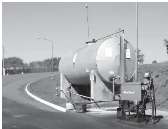
Figura 1 Foto do tanque utilizado para preparação e abastecimento da mistura álcool/diesel.
