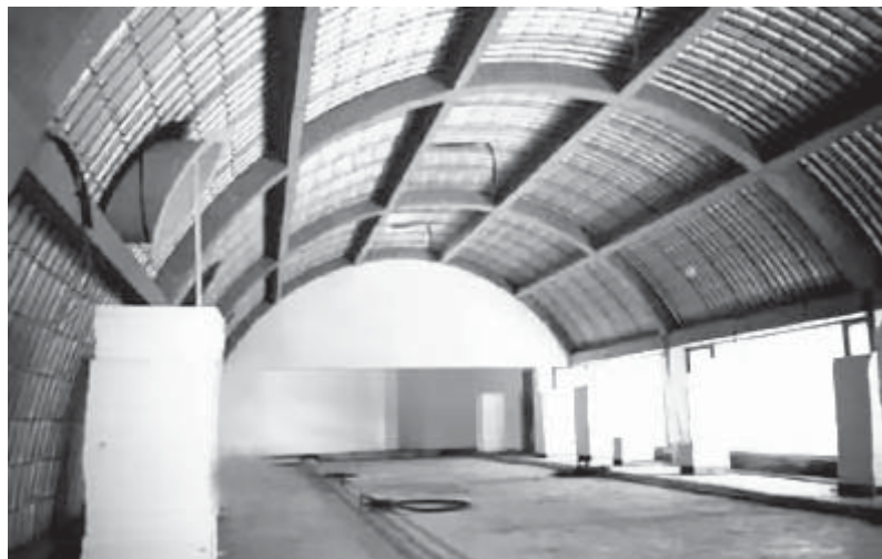
Figura 7 Cobertura protegida com placas de lã de rocha.
