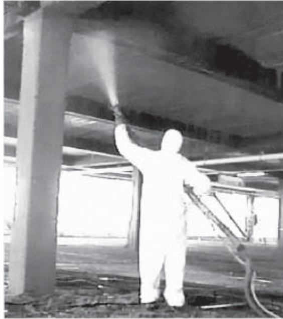
Figura 6 Aplicação de argamassa por jateamento.
