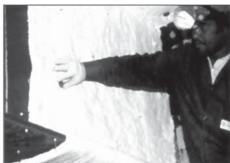
Figura 8 Centro Empresarial do Aço protegido por manta de fibra cerâmica, São Paulo – SP: vista geral e detalhes da fixação da manta de fibra cerâmica em perfil soldado tipo I, por meio de pinos e arruelas de pressão.
