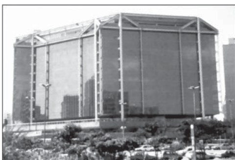
Figura 8 Centro Empresarial do Aço protegido por manta de fibra cerâmica, São Paulo – SP: vista geral e detalhes da fixação da manta de fibra cerâmica em perfil soldado tipo I, por meio de pinos e arruelas de pressão.
