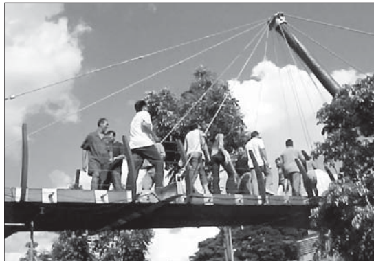
Figura 9 Vista lateral dos pedestres caminhando sobre a passarela.
