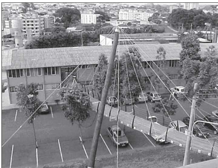
Figura 1 Passarela estaiada de madeira construída na Escola de Engenharia de São Carlos – Universidade de São Paulo (EESC-USP).
