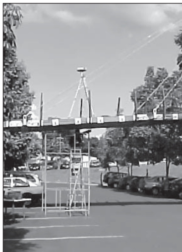
Figura 5 Antena GPS móvel instalada sobre o tabuleiro da passarela e transdutor de deslocamento sob o tabuleiro.
