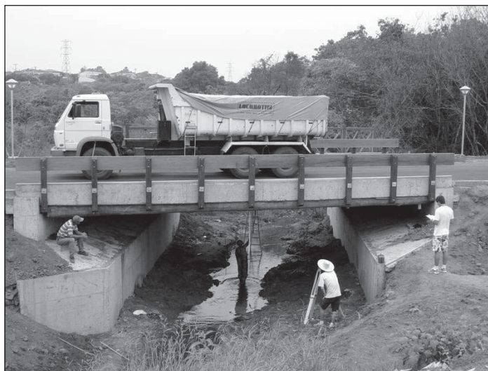
Figura 1 Ponte mista madeira-concreto no Campus II da EESC-USP.
